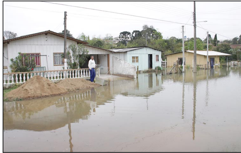
▲ Vila Ferroviária (casa de Isidoro da Silva)
