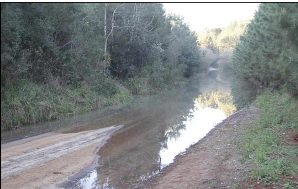
▲ Estrada geral Estação Canivete tomada pelas águas, teve o acesso prejudicado para o transporte escolar
