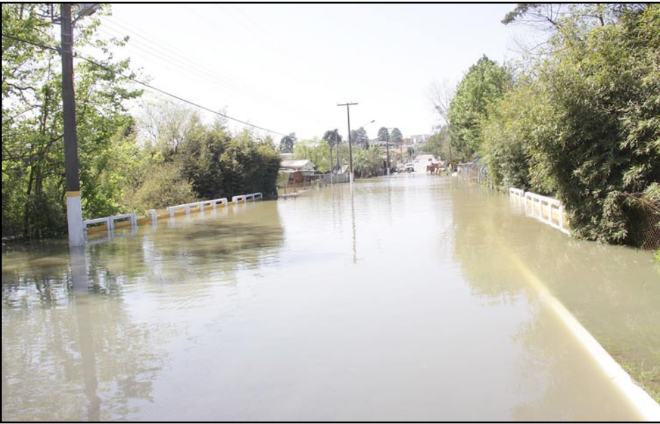
▲ Ponte na Rua São João Maria
